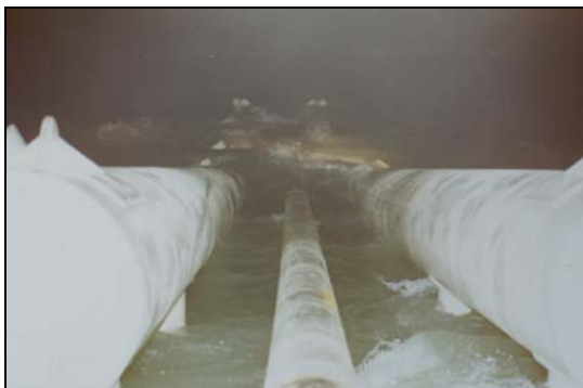
Verlegearbeiten mit der McDermott DB 9
