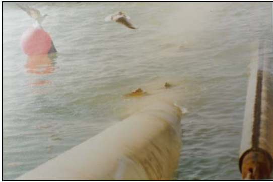
Ablegen der Rohrstranges über den Stinger;
