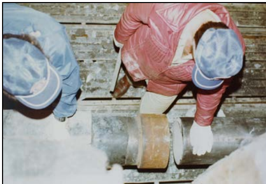
Zusammenführen der Rohrstränge;
