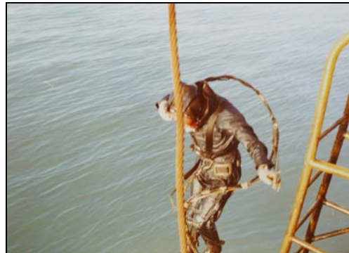
Taucherkontrolle nach dem Tie-In
