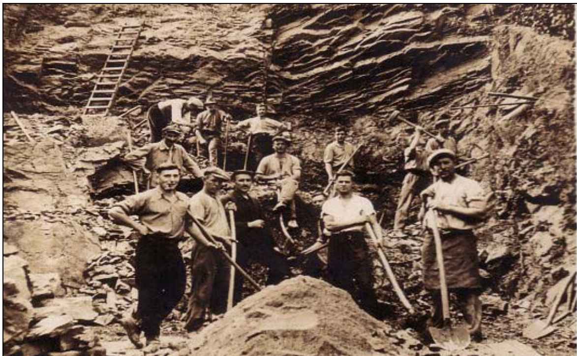
Abb.: 4 Ausschachtungsarbeiten zum Kellerneubau des Dernauer Winzervereines (1935)
